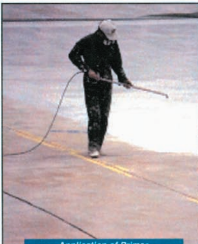
Application of Primer
