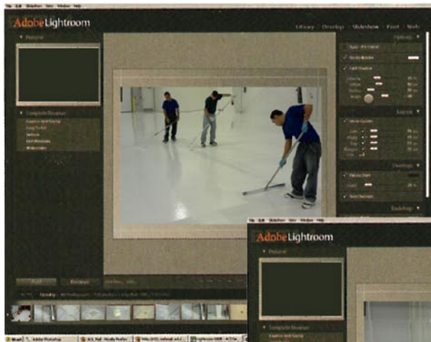
E31-1202-64 Epoxy Primer Started/Applied
